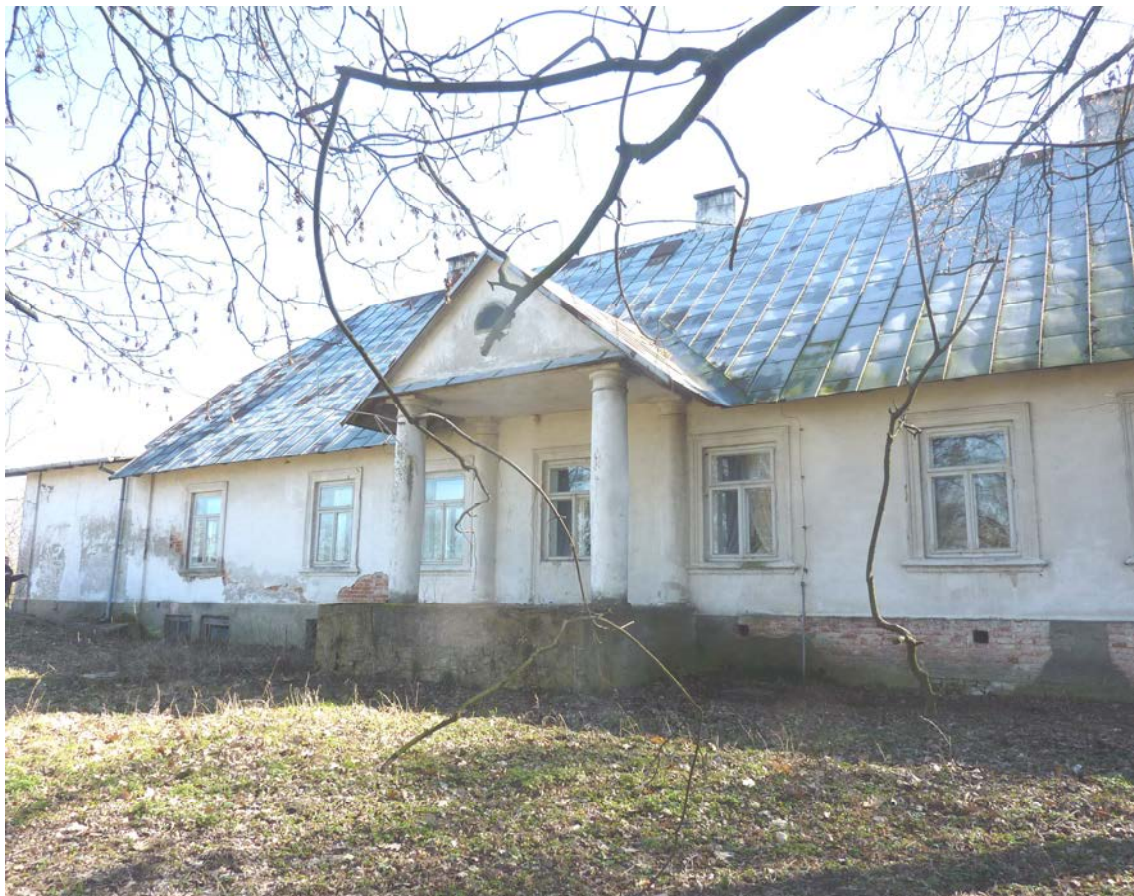
Fot.4 Część elewacji północno-zachodniej
