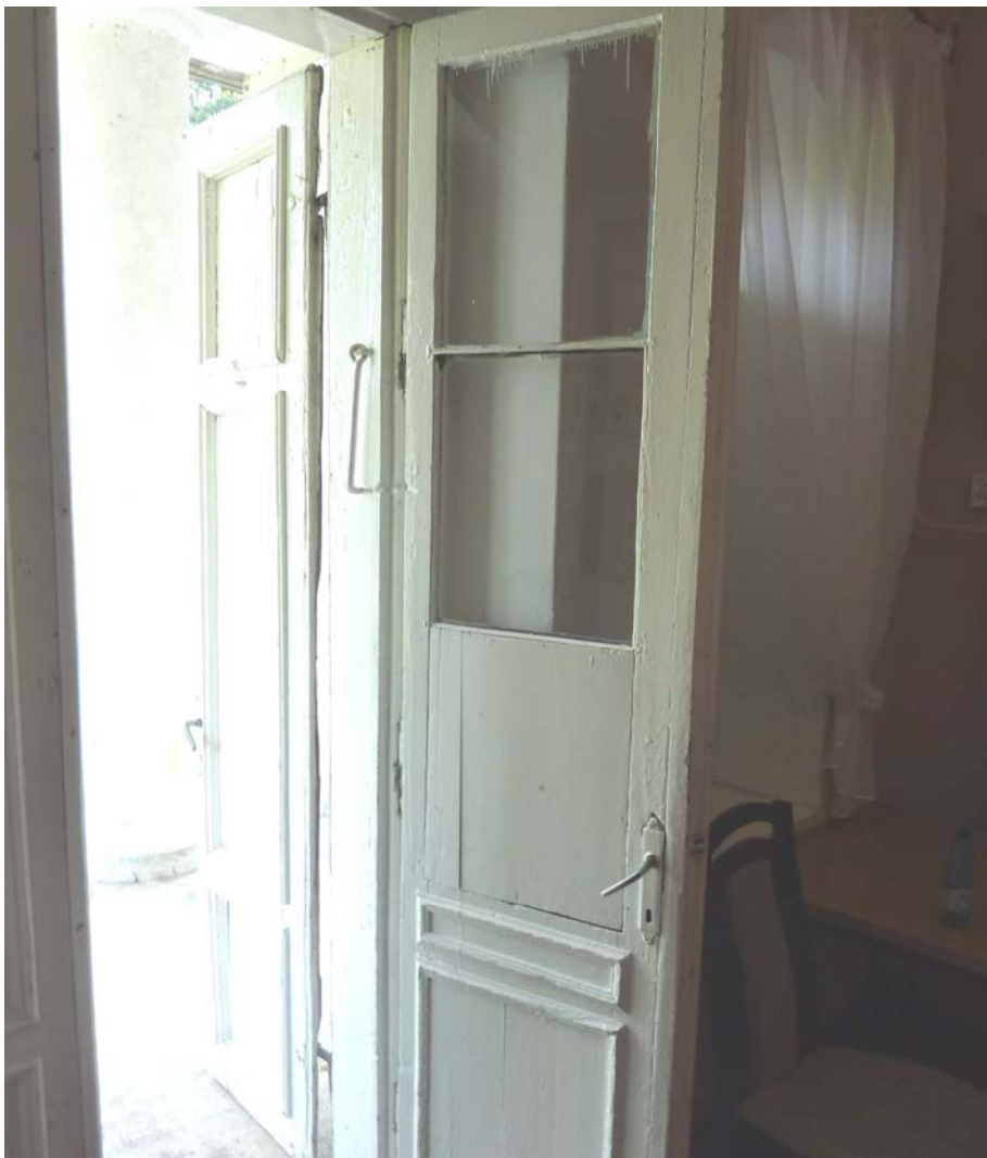
Fot.18 Widok drzwi głównych wejściowych ramowo-płycionowych
