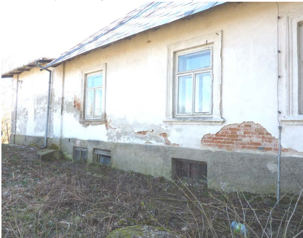
Fot.6 Część elewacji północno-zachodniej
