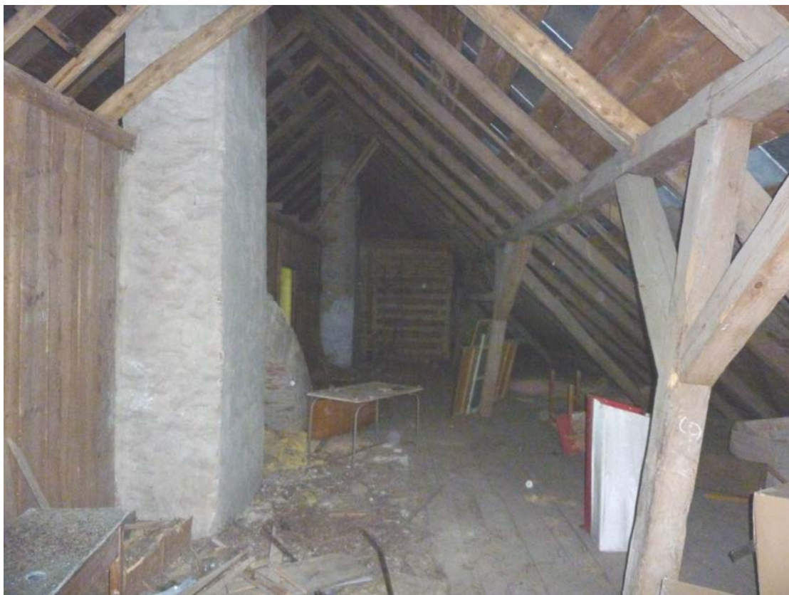
Fot.13 Widok konstrukcji dachowej ze stolcem kozłowym
