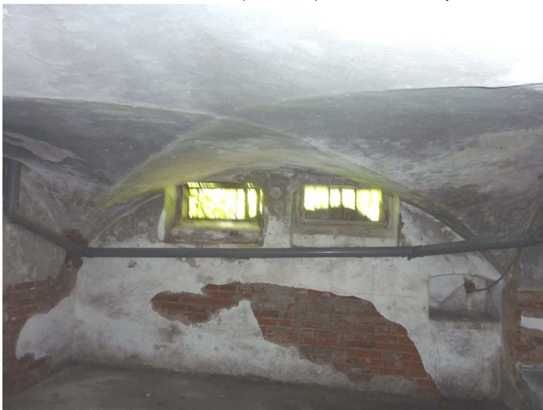
Fot 14 Widok pomieszczenia 0-7
