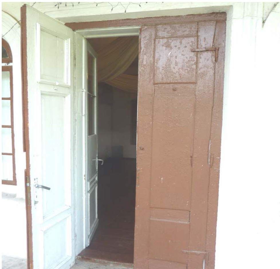
Fot. 19 Widok drzwi głównych wejściowych od strony zewnętrznej
