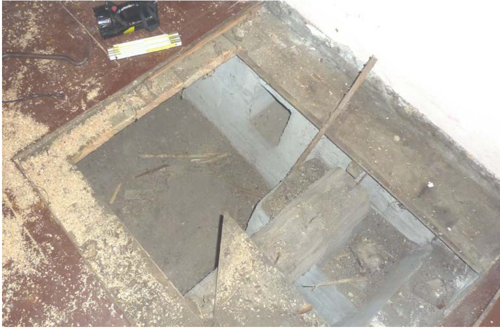
Fot.15 Odkrywka podłogi historycznej drewnianej w pom. 1-3
