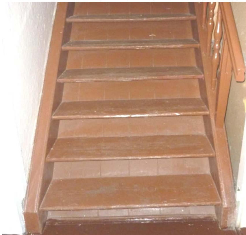
Fot. 20 Widok schodów wewnętrznych prowadzących na poddasze
