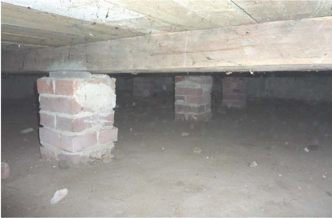
Fot. 17 Widok przestrzeni podpodłogowej w pom. 1-3
