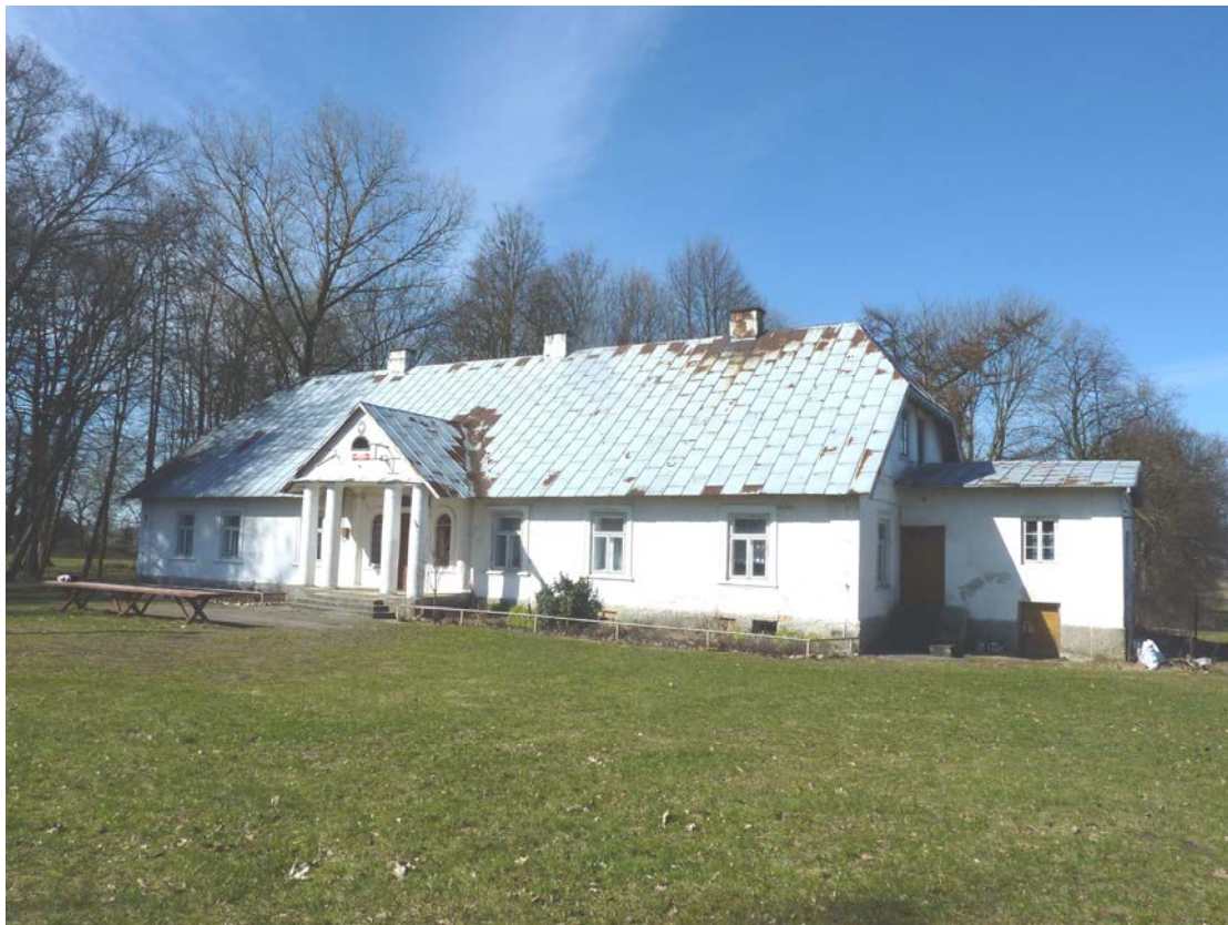
Fot. 1 Elewacja frontowa – południowo-wschodnia
