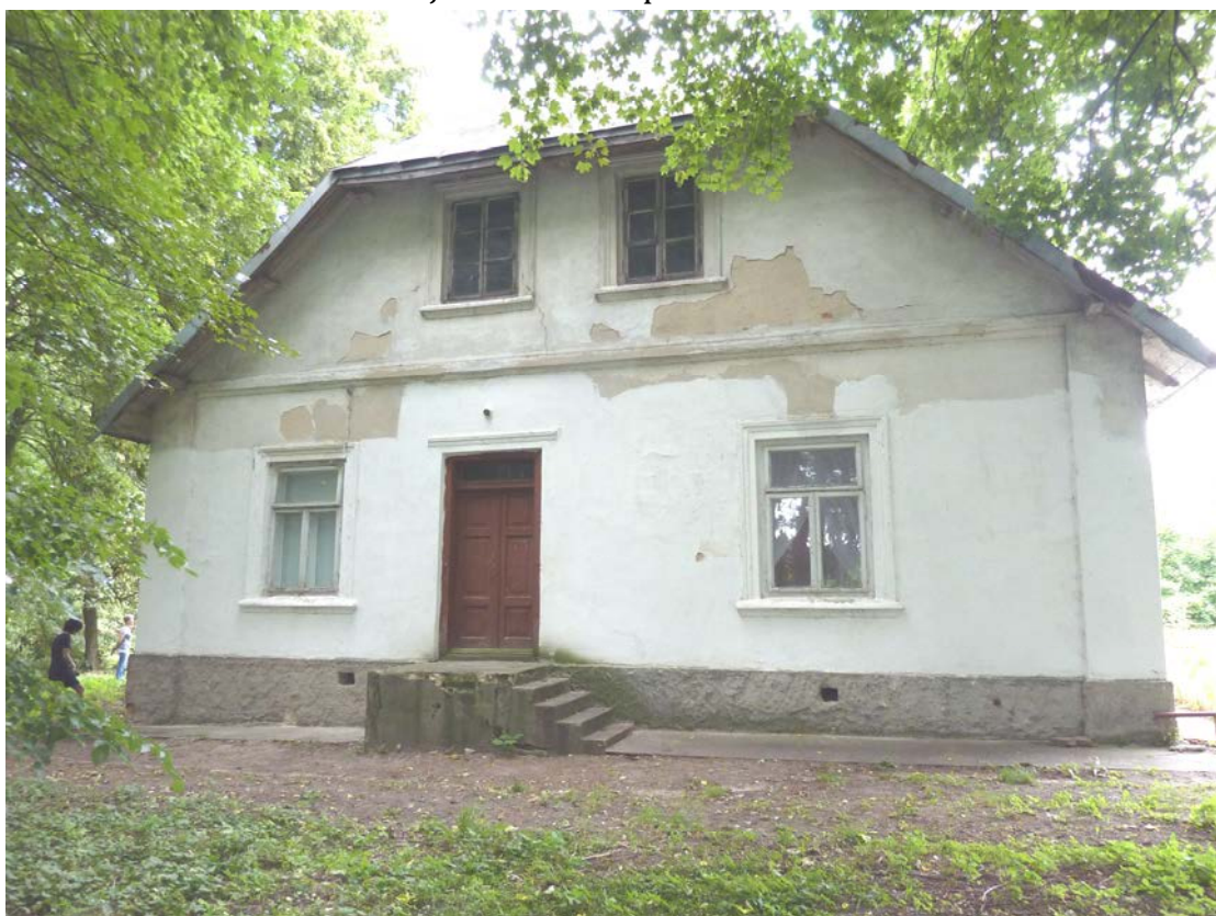
Fot.2 Część elewacji południowo-zachodniej
