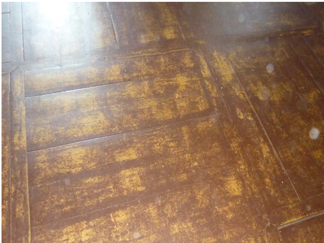
Fot.16 Widok podłogi historycznej drewnianej w pom. 1-3 z desek 32mm
